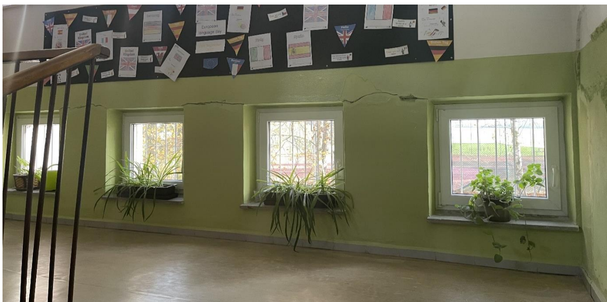
Obrázek 13: Schodiště, mezipodesta – oddělení zděného pilíře od betonového věnce
