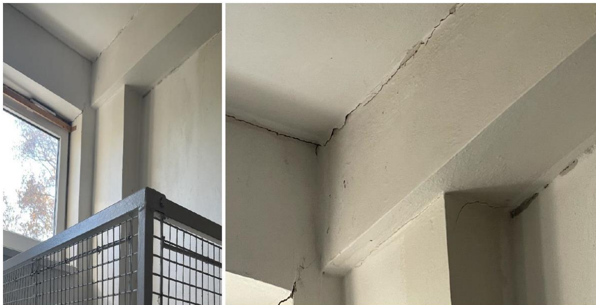
Obrázek 6: Místnost s bojlerem, detail poruch u styku příčného rámu a výplňových konstrukcí
