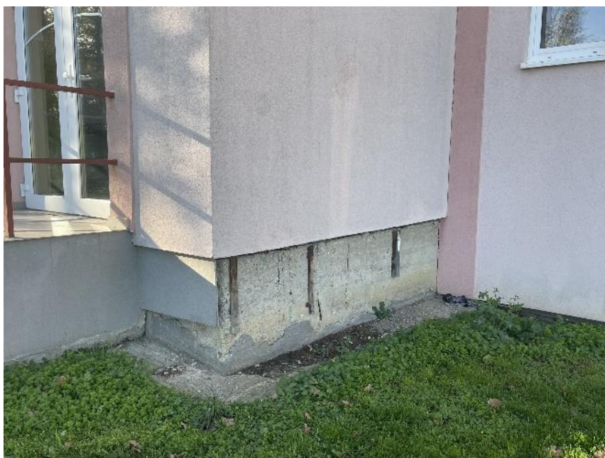
Obrázek 25: Nevhodně vyspárovaný povrch terénu (dešťová voda stéká k obvodové zdi)
