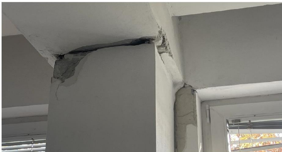
Obrázek 9: Dílna kovo, detail styku sloupu a průvlaku u obvodové zdi
