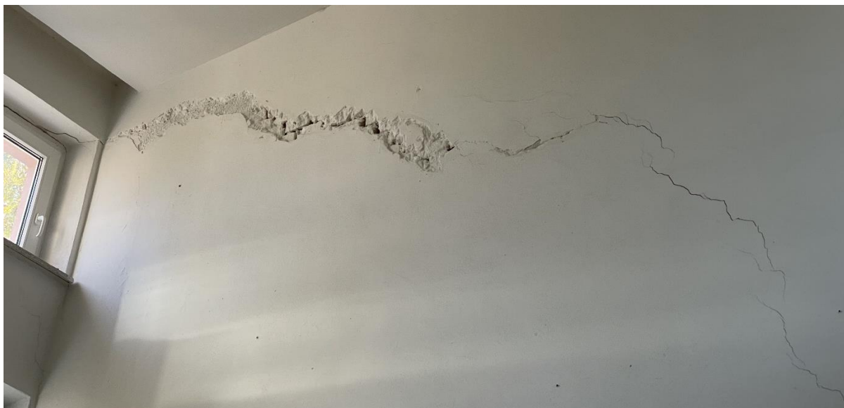
Obrázek 16: Detail trhliny v pravé schodišťové zdi pod střešinou (viz předchozí obr)
