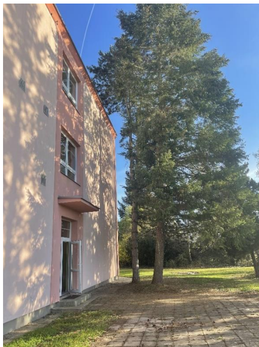
Obrázek 24: stromy v blízkosti objektu, nevhodně vyspárovaný povrch terénu (dešťová voda stéká k obvodové zdi)
