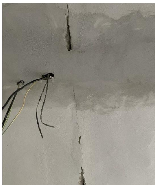
Obrázek 11: (Pravděpodobně) necitlivě vedená elektřina, cca uprostřed rozpětí panelů zasekána do krycí vrstvy
