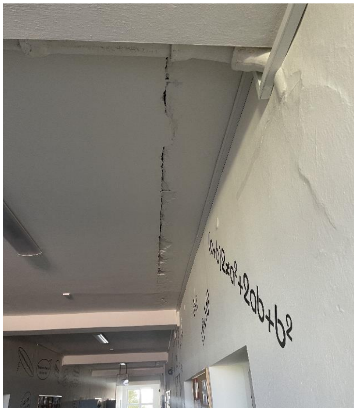
Obrázek 18: Detail trhliny mezi střešními panely, 3.NP
