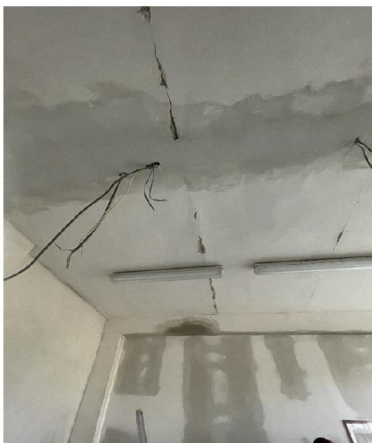
Obrázek 11: (Pravděpodobně) necitlivě vedená elektřina, cca uprostřed rozpětí panelů zasekána do krycí vrstvy
