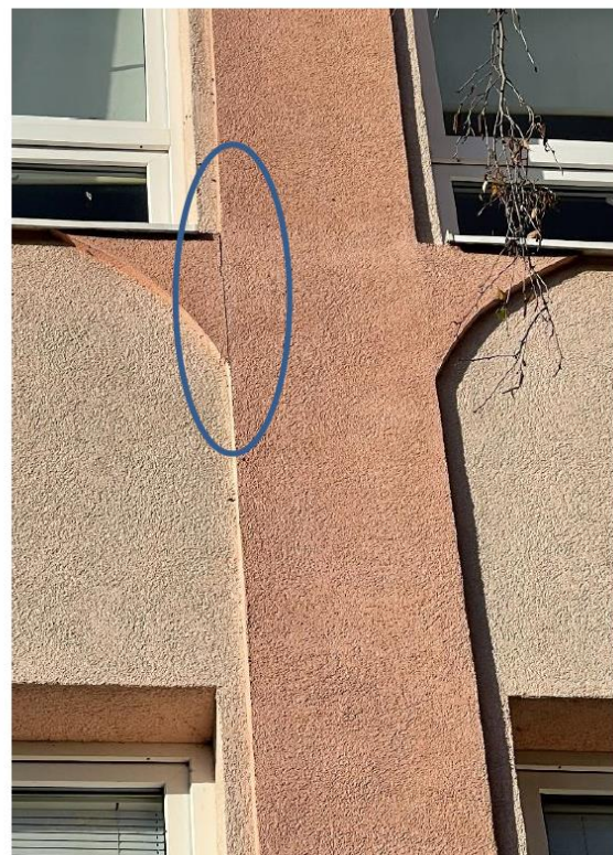
Obrázek 3: Poruchy na zateplovacím systému
