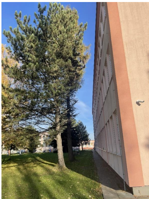
Obrázek 24: stromy v blízkosti objektu, nevhodně vyspárovaný povrch terénu (dešťová voda stéká k obvodové zdi)
