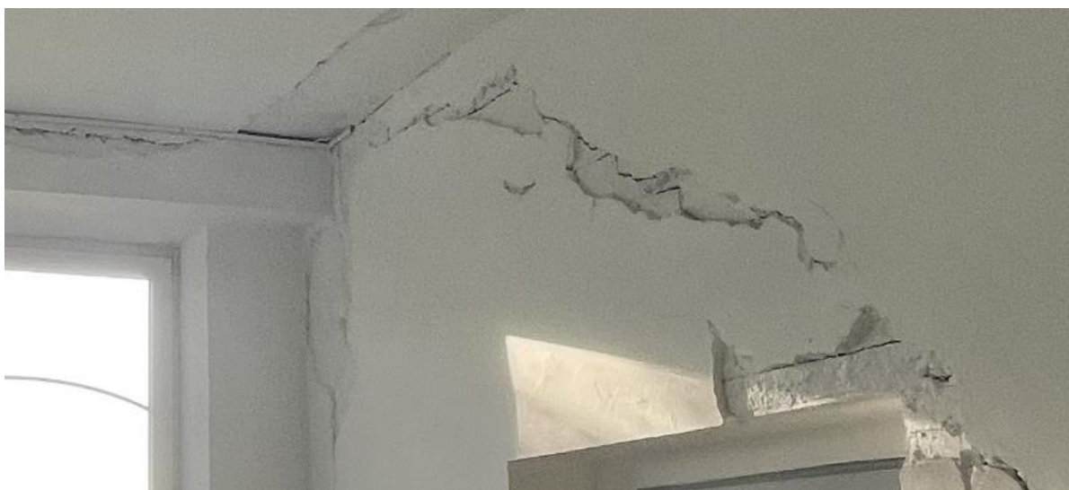
Obrázek 23: Detail trhliny v pravé příčce z Obrázek 20, obvodová zeď a stropní panel
