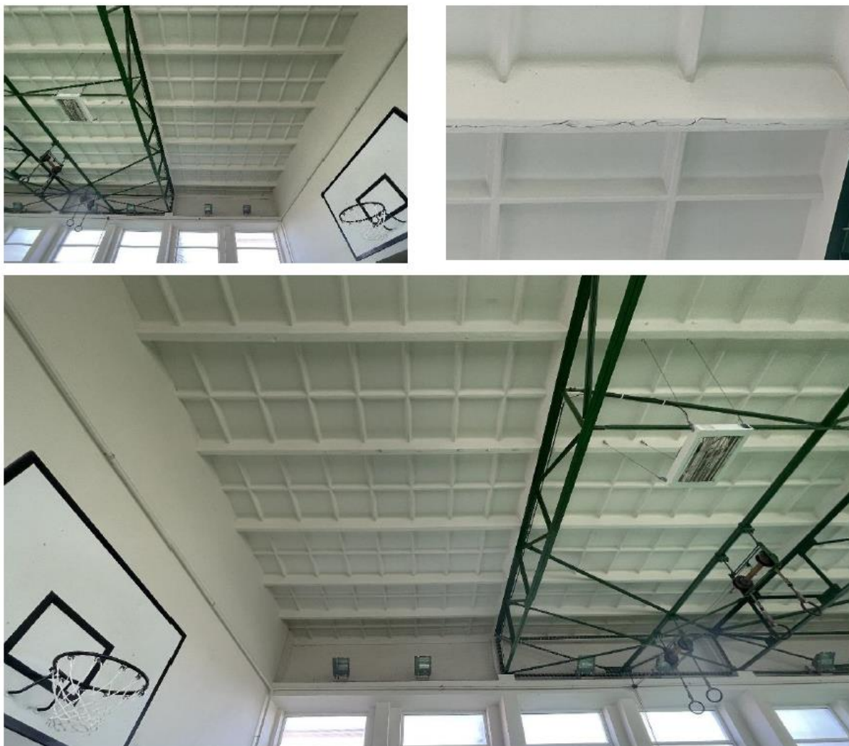
Obrázek 5: Tělocvična, prohnuté střešní panely, trhliny ve styku střešních panelů
