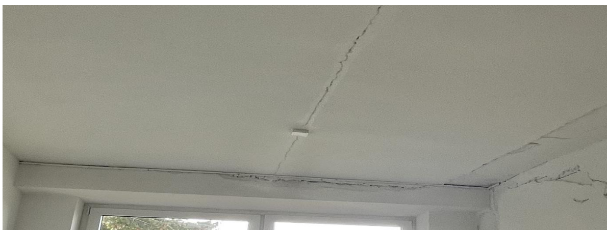
Obrázek 22: Spára mezi stropními panely ve skladu z předchozího obr
