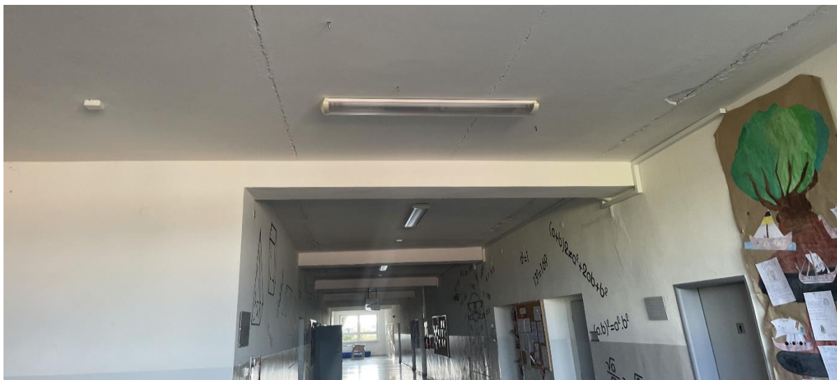
Obrázek 17: Celkový pohled na chodbu ve 3.NP; zřetelné spáry mezi střešními panely
