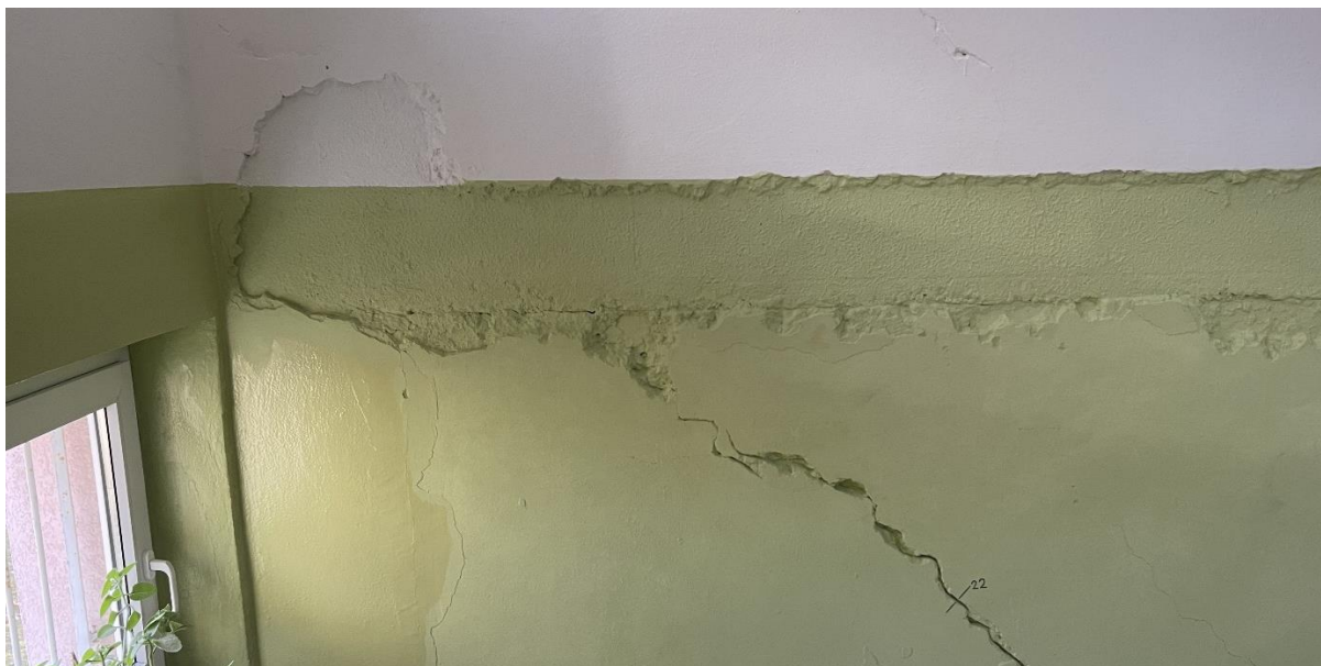
Obrázek 12: Prostor schodiště, věnec nad mezipodestou, odpadáá omítka, ale betonová kce neporušená
